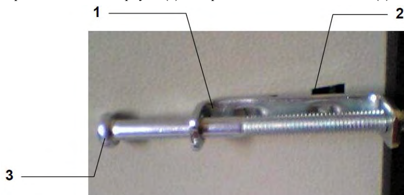
Рис. 3 Крепление скобы устройства к панели.
